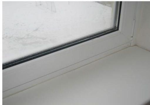
Kombinierte Thermo- & Hygrometer, welche der Kontrolle der Temperatur und Luftfeuchtigkeit im Innenraum sowie als Hilfsmittel zum Lüftungstraining dienen können, haben sich in der Praxis erfolgreich zur Vermeidung von Schimmelpilzwachstum bewährt. Ein weiteres untrügliches Merkmal für ein falsches Lüftungsverhalten wäre das Beschlagen von isolierverglasten Fensterscheiben. Im Bereich des Glasrandverbundes kondensiert der in der Luft enthaltene Wasserdampf und Tau- bzw. Kondenswasser fällt aus.
